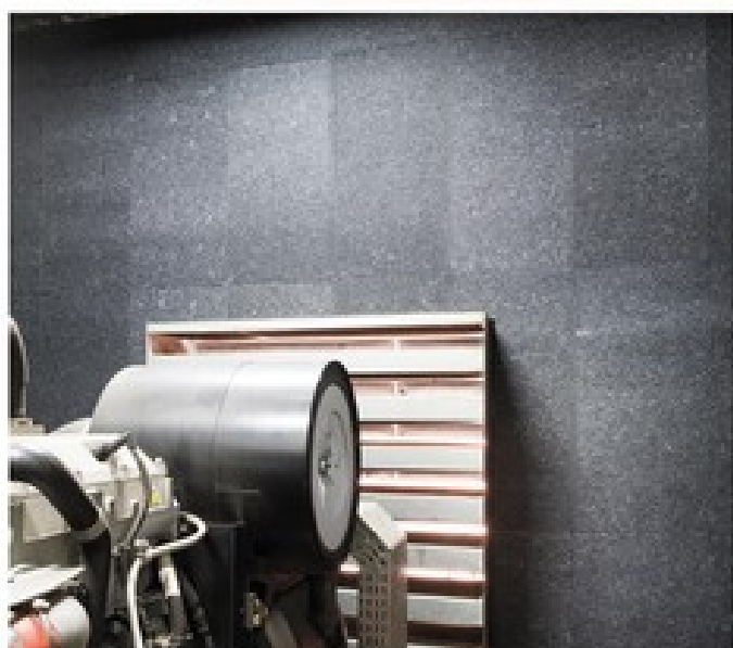
Casa de máquinas
